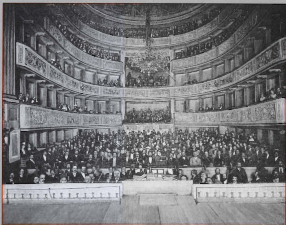
Widownia Teatru Wielkiego przed przebudową (fot. A. Karoli i M. Pusch)
